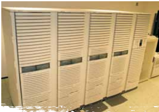
Serwery teleinformatyczne. Autor: Waldemar Sudak
